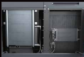
Komponenten des Kühlsystems
